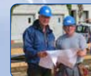
Elektro- installationen aller Art
